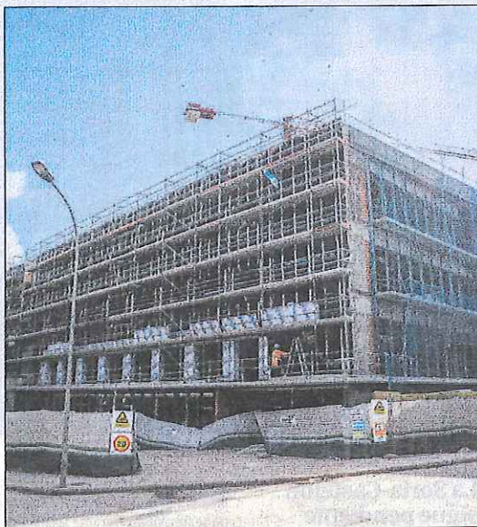
Obras en el Hospital Santa Bárbara de Soria. MONTESEGUROFOTO
